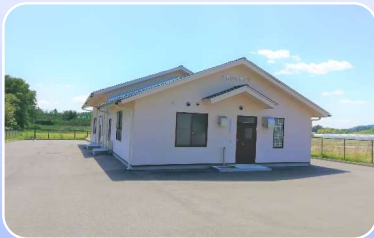
大泉農業集落排水処理施設
