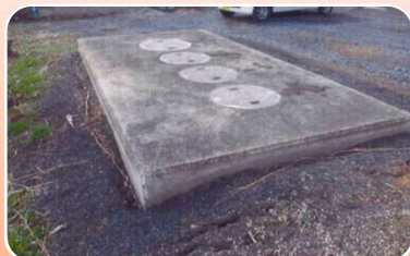
整備された浄化槽
