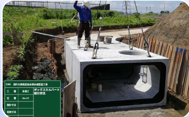
雨水排水路築造工事の様子
