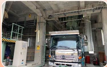
汚泥運搬の様子
